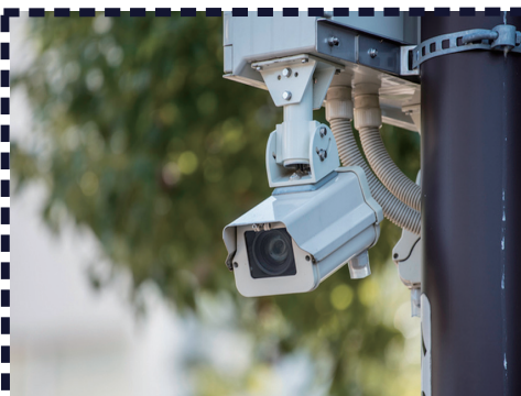
防犯カメラ設置工事
