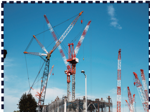
クレーン作業現場
