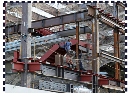
高所作業現場
