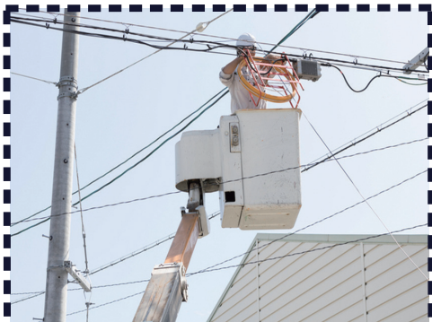
電気や電話・LANの配線設置工事
